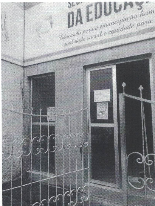
FOTO 02: ESQUADRIAS DA FACHADA
