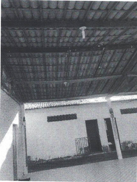
FOTO 05: TELHADO DO PÁTIO
