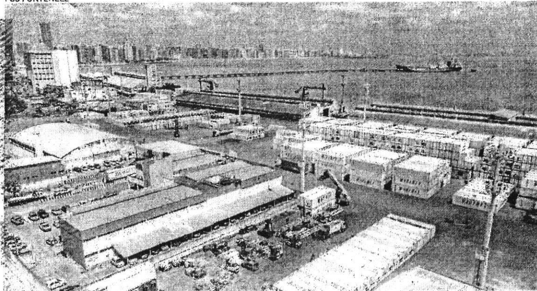
TERMINAL de contêineres do Porto de Fortaleza deve
