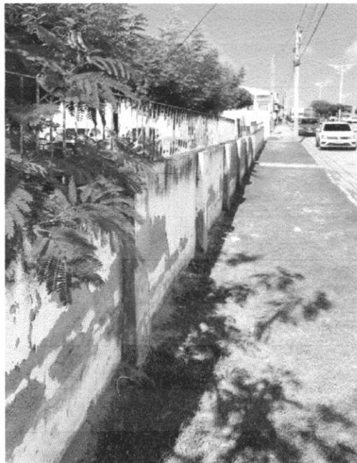
MURO VISÃO EXTERNO
