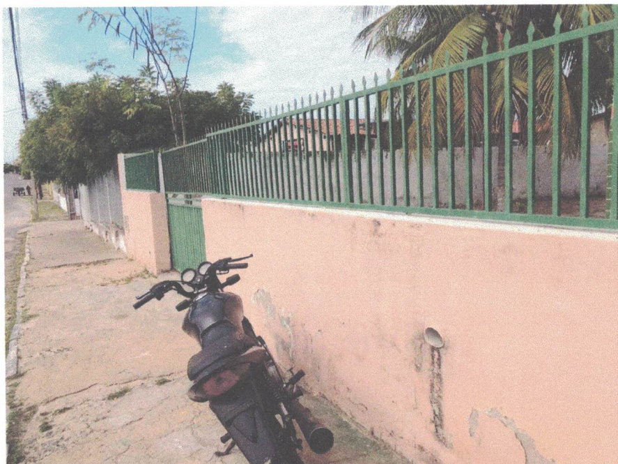
FOTO 04: MURO DA FACHADA
